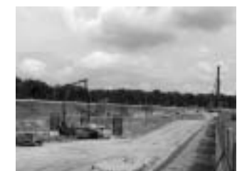
東部丘陵線の工事現場
