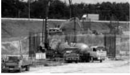
万博にむけ急速に進められる東部丘陵線工事
