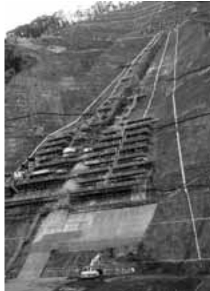
徳山ダムは土と岩を積み上げてつくるロックフィル式。山の斜面に引かれた白い線にそって核となる土石が積み上げられるが、今はまだ土台部分の整地段階。
