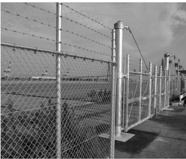
設置されたフェンスには鉄条網も(名古屋港金城埠頭)
