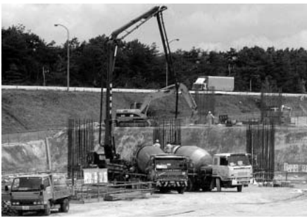
万博にむけ急速に進められる東部丘陵線工事
